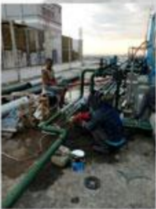
INSTALASI PIPA AIR BERSIH
