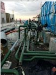
INSTALASI PIPA AIR BERSIH
